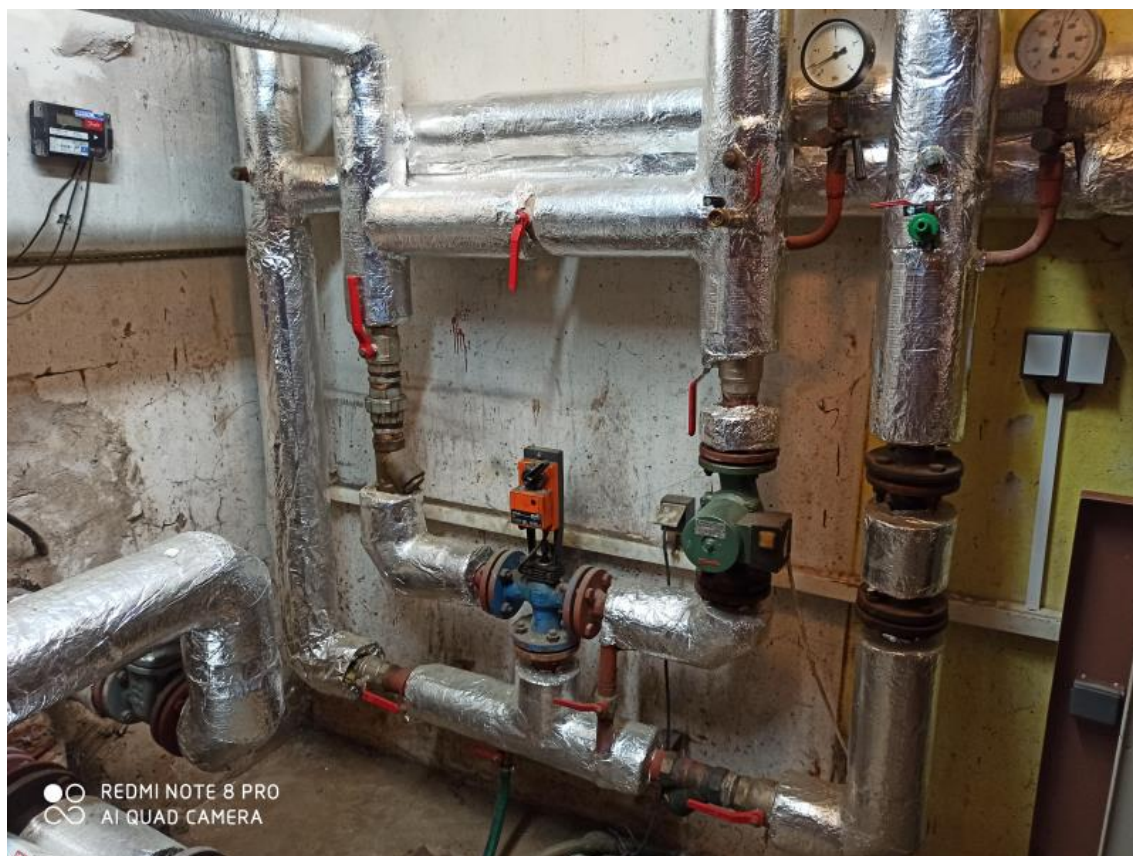
Obr. č. 5 – výměníková stanice CP577
